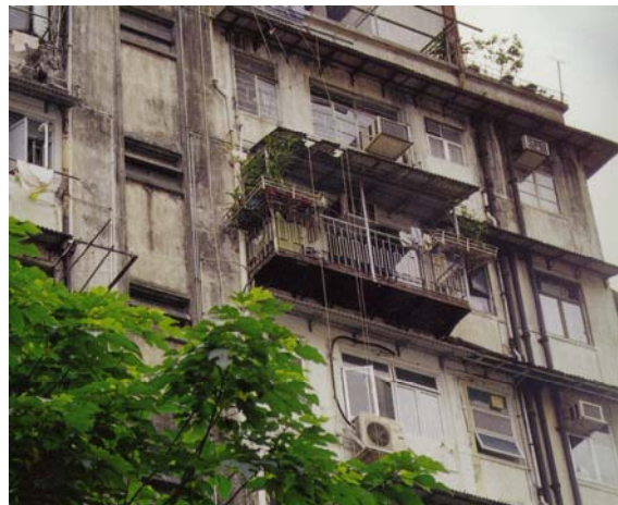
写真1 改修前の様子
