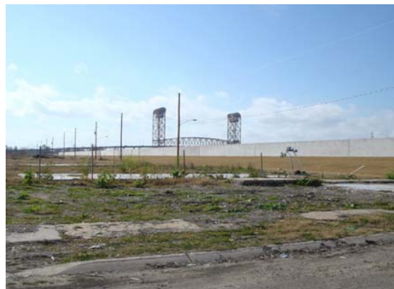
写真 1 Lower 9 th Ward の状況 (2006 年 12 月に筆者が撮影) 堤防が決壊して甚大な被害を受けた地区では人口は戻るのか?
