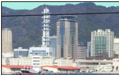
図-6 NTT 西日本神戸中央ビル
