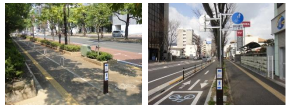
国道11号 市道5番町西宝線 図-6 自転車走行空間の整備状況
