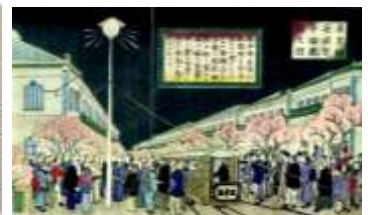
図-10 「東京銀座通電気燈建設之図」よりアーク電灯
