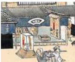
図-5 「熙代勝覧の日本橋」より辻行灯
