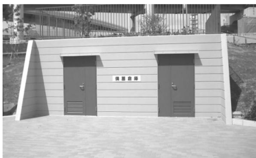
写真-2 公園内の備蓄倉庫
