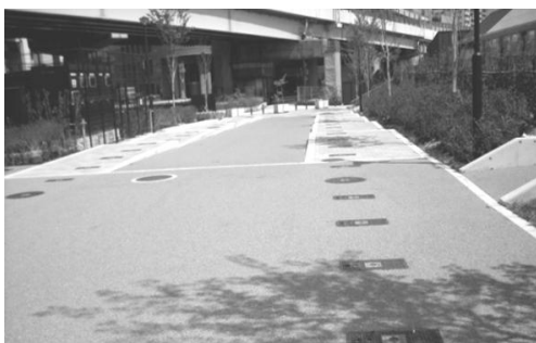
写真-1 災害発生時用の仮設トイレ用マンホール
