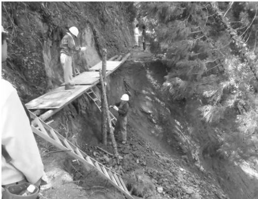
図-2 道路の復旧作業の様子(提供:K地区住民)
