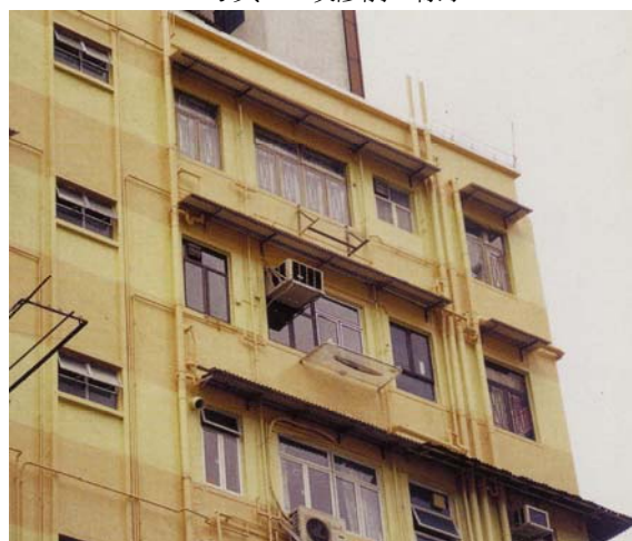
写真2 改修後の様子
