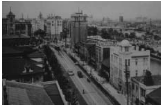
土佐堀通り(北浜)を東から西に見た近代の風景 通り沿いには近代建築が並ぶ
