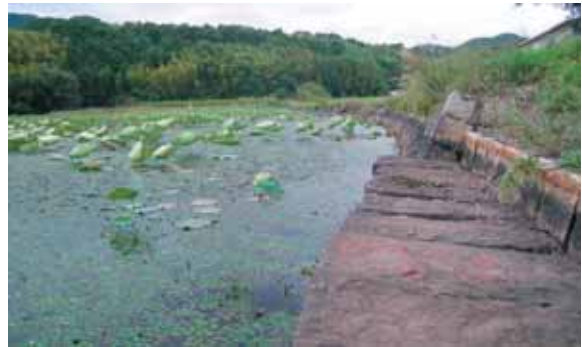
写真1 石積み土手の残るため池。手前は石を方持ちでせり出させた洗い場。洗濯板と呼ばれる。
